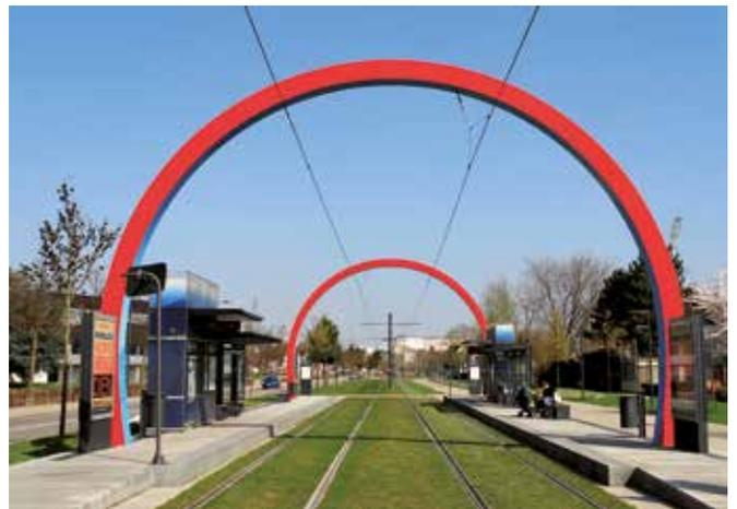
**Mulhouse** | Extravagante Landmarke: Der Ersatz der Oberleitungsmasten durch bunte Portalkonstruktionen hebt die Haltestellen im Stadtraum unübersehbar hervor.
